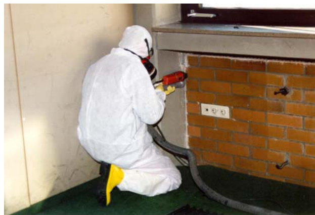
Abbildung 6: Entfernung der Fugenmassen
