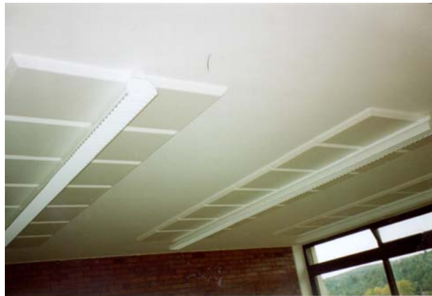
Abbildung 12: Fertige Decke nach der Sanierung
