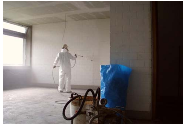
Abbildung 11: Beschichtung der Oberflächen mit PF-2-Combi
