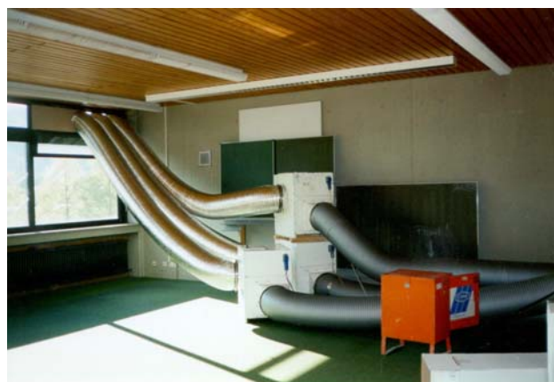
Abbildung 5: Zufuhr von Frischluft mit starken Gebläsen
