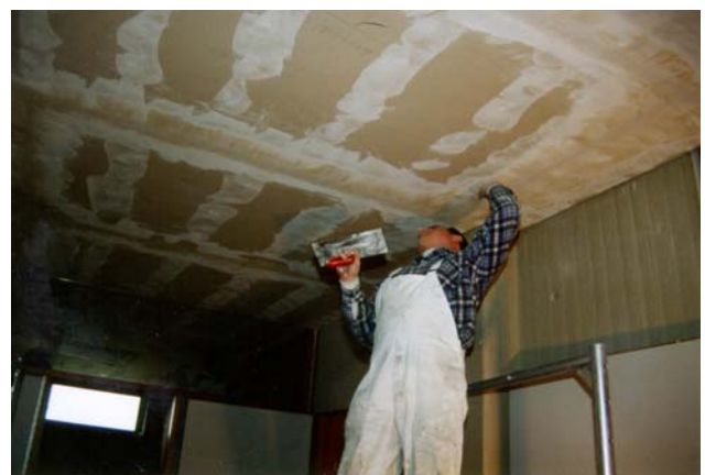
Abbildung 10: Fertigstellung der Deckverkleidung
