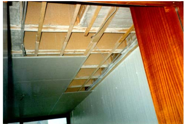
Abbildung 9: Einbau der neuen Deckenverkleidung
