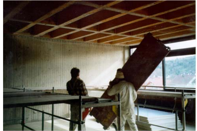
Abbildung 8: Entfernung der Deckenverkleidung
