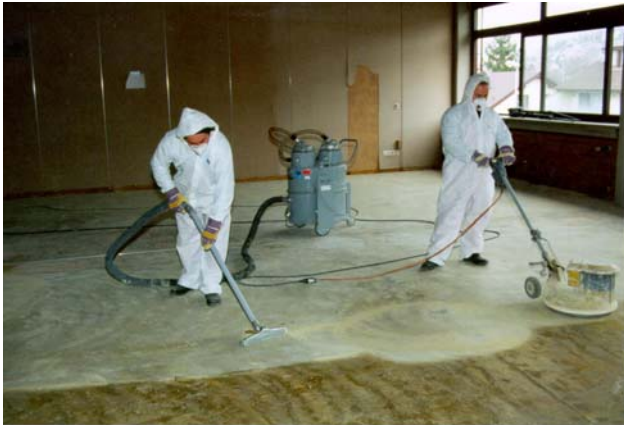
Abbildung 7: Entfernung von Klebstoffresten und Staubbeseitigung
